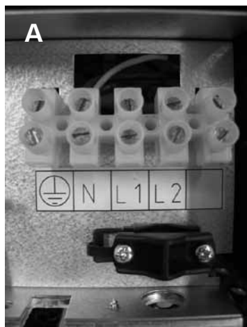
Рисунок 10 А и В. 2-фазные электрические соединения каменки
