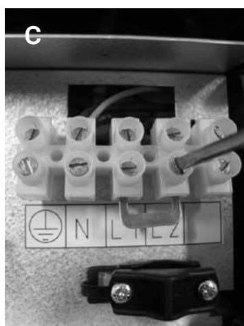
Рисунок 10 С и D. 1-фазное соединение каменки
